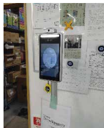
入室時の検温装置設置
