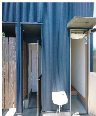
トイレ＆シャワー室
